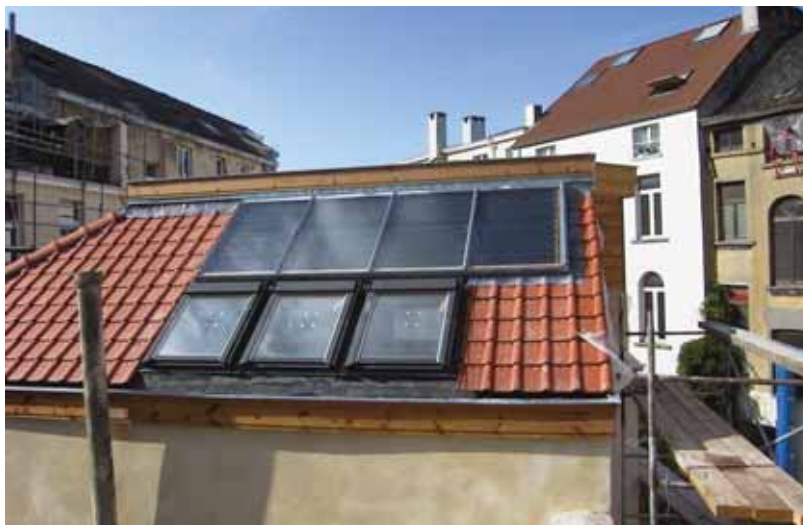
Construisez votre propre panneau solaire avec les ateliers de la rue Voot
